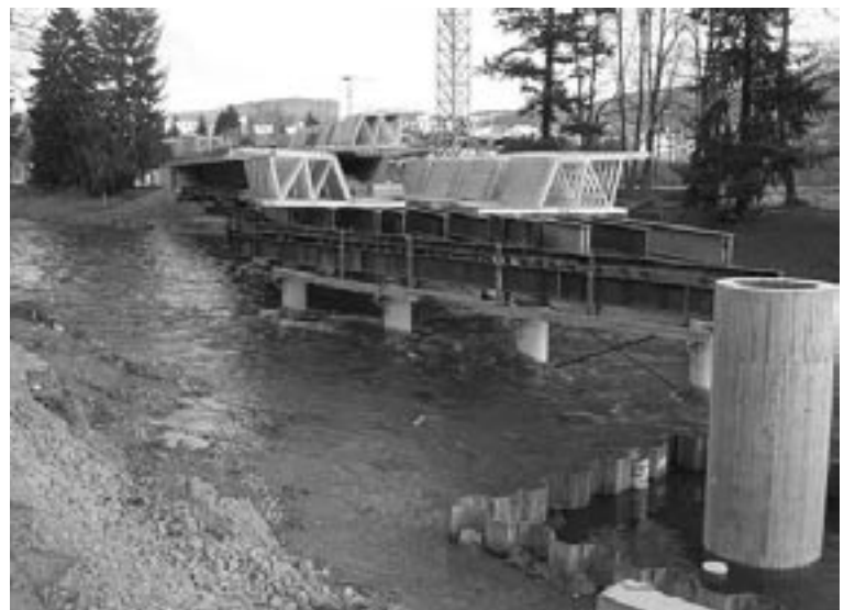
Stand der Bauarbeiten bei der Zollfreien. Photo Kristian Persohn
